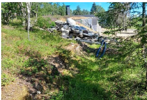
Kuva 12. Keskeneräinen rakennus ja purkujätettä Äkäsjoen varrella. Oikealla tasoitettua jokipenkkaa. Etelästä.
