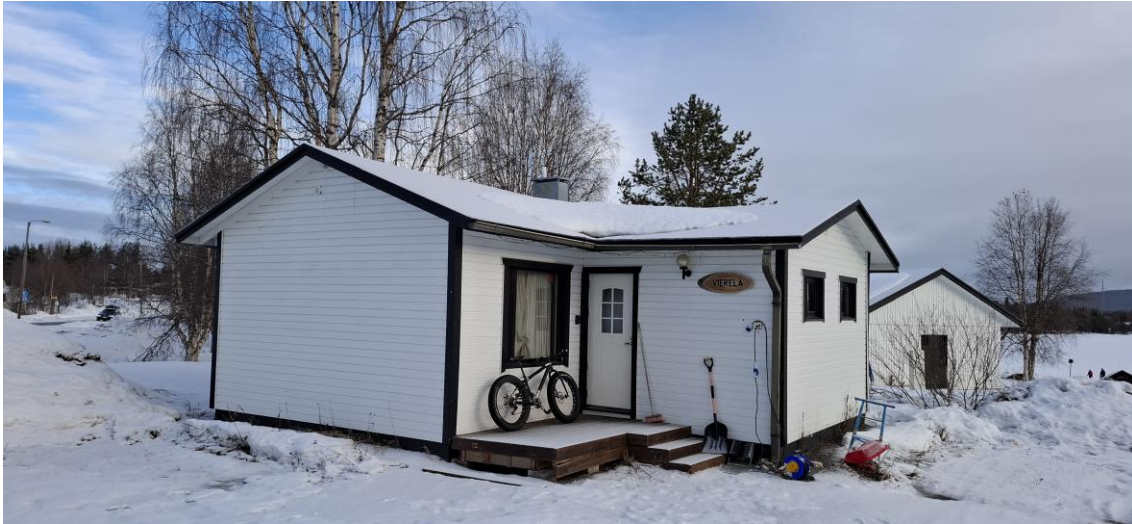
Kuva 21. Tiurajärventie 1, Pieni kausityöntekijöiden asuinrakennus Tiurajärventien varressa.
