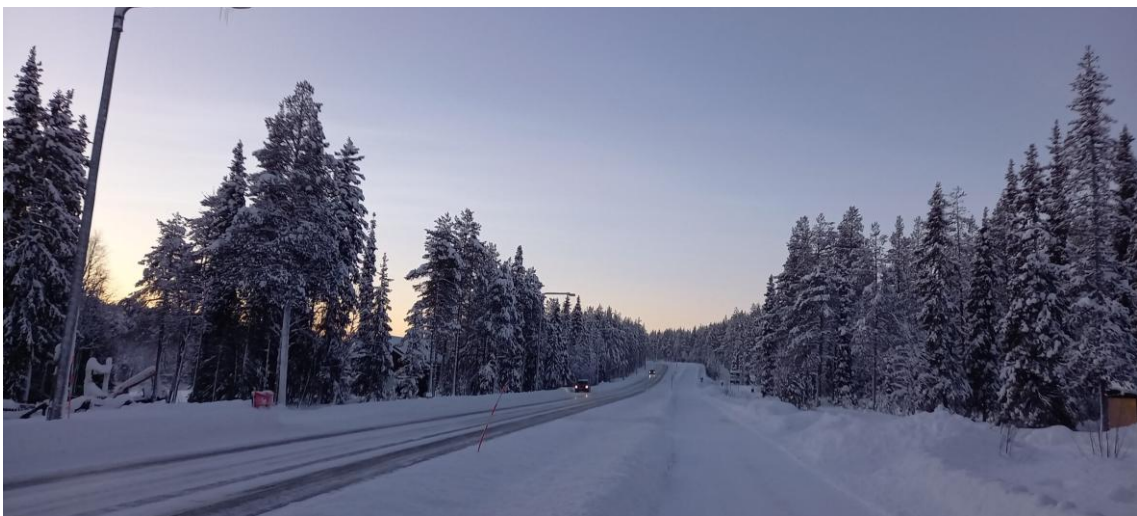
Kuva 3. Lompolontie on yleinen tie (940).
