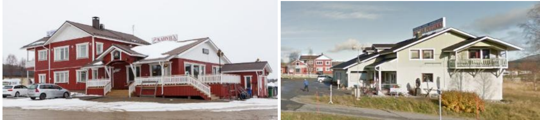
Kuva 96. Ylläksen Ykkös Caravan-alueen rakennuksia, kahvila ja Mailan putiikki
