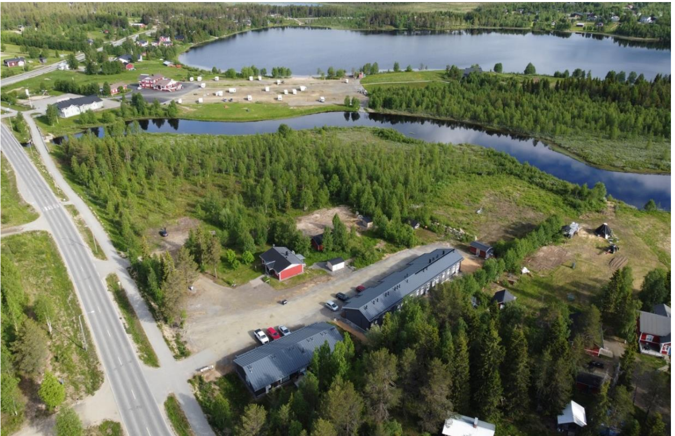
Kuva 14. Viistokuva idästä suunnittelualueelle. Etualalla näkyy kaavamuutosalueeseen rajautuva rivitalorakennukset, omakotitalo ja pumppuasema. Taustalla Äkäsjoen vastarannalla erottuu caravan-alue huolto- ja asuinrakennuksineen. © Insinööritoimisto Renderoi Oy 2022.
