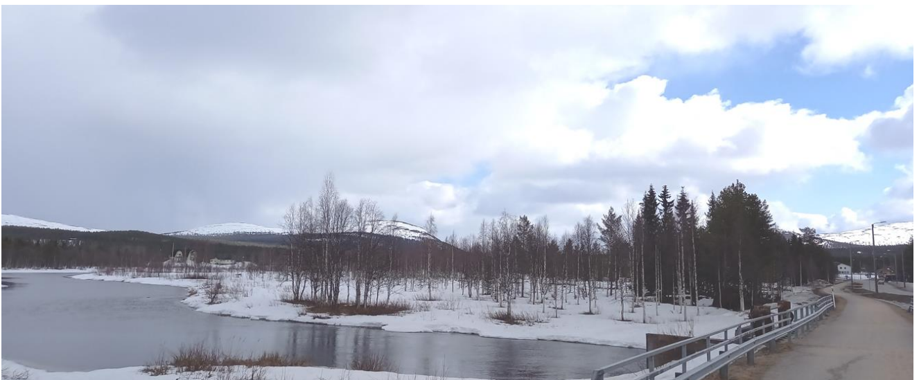
Kuva 12. Näkymä Tunturintieltä itään suunnittelualueelle. Etualalla oikealla Äkäsjoen ylittävä silta patorakenteineen. © J.Lokio 2022.
