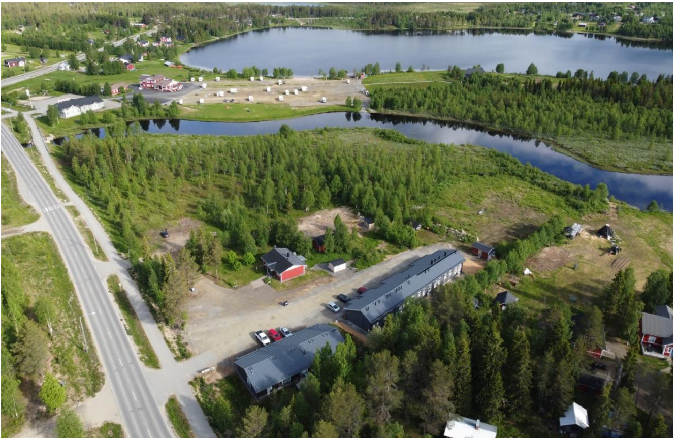
Kuva 14. Viistokuva idästä suunnittelualueelle. Etualalla näkyy kaavamuutosalueeseen rajautuva rivitalorakennukset, omakotitalo ja pumppuasema. Taustalla Äkäsjoen vastarannalla erottuu caravan-alue huolto- ja asuinrakennuksineen. © Insinööritoimisto Renderoi Oy 2022.
