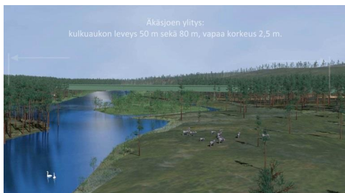
Kuva 6-20 Kuljetin ylittää Äkäsjoen noin 170 m pitkällä sillalla (kuvakaappaus videosta, Diff Design Oy).
