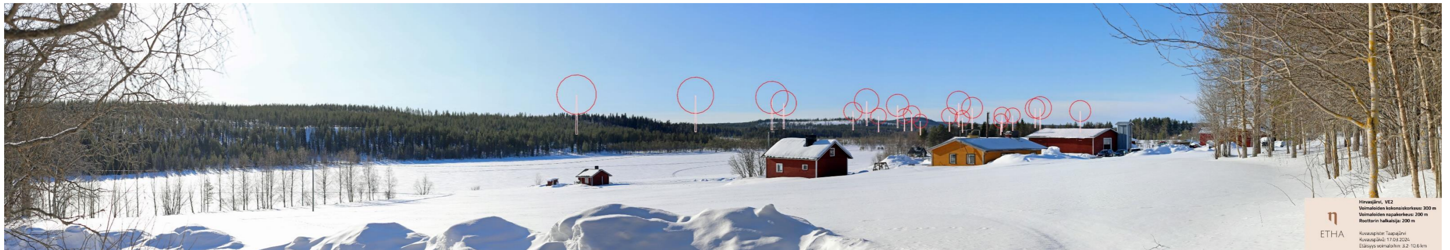
Kuva 3.5. Havainnekuva Taapajärven kyläalueelta, kylän eteläosasta. Kuvassa on korostettu voimaloiden tornit valkoisilla viivoilla ja lapojen pyörimisaluet punaisilla ympyröillä.
