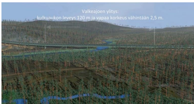
Kuva 6-21 Kuljetin ylittää Valkeajoen noin 170 m pitkällä sillalla (kuvakaappaus videosta, Diff Design Oy).
