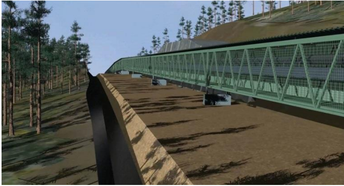
Kuva 6-22 Kuljetin sijoittuu maastoleikkaukseen pieneltä matkalta Saivoharjun kohdalla, muutoin kuljetin seuraa maan pinnan muotoja (kuvakaappaus videosta, Diff Design Oy).
