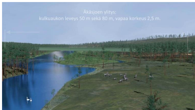
Kuva 6-20 Kuljetin ylittää Äkäsjoen noin 170 m pitkällä sillalla (kuvakaappaus videosta, Diff Design Oy).
