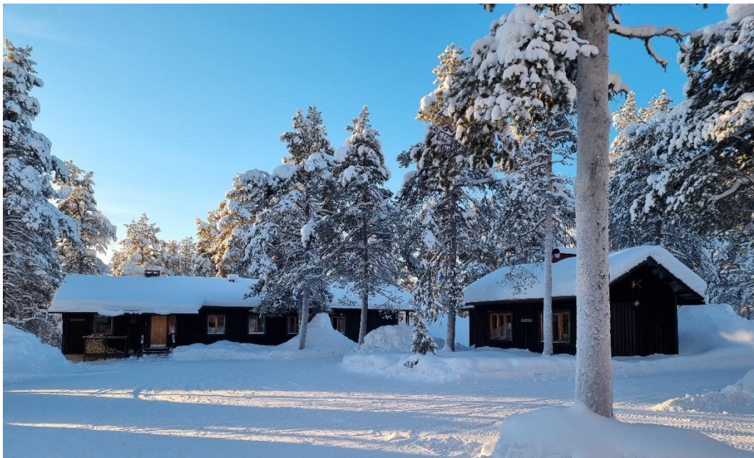
Kuva 102. Stenan pihapiirissä on vanhan majan lisäksi myös muita majoitusrakennuksia.
