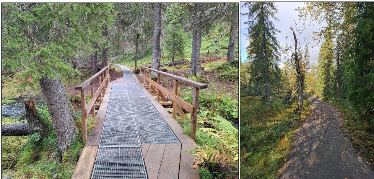
Kuva 4. Varkaankurunpolun teräsrakenteisia pitkoksia (vas) sekä sorapintaista kestävyöityä reittiä (oik).
