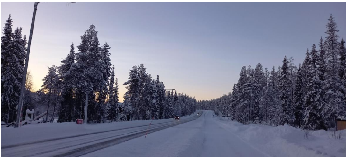
Kuva 3. Lompolontie on yleinen tie (940).
