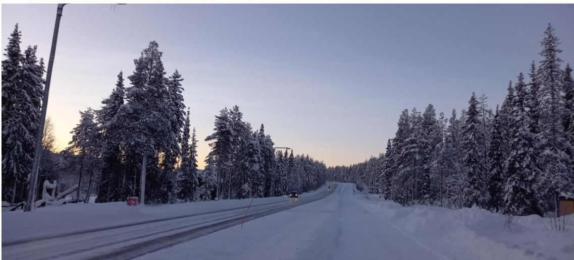
Kuva 3. Lompolontie on yleinen tie (940).
